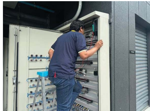
ดูแล ตรวจสอบตู้ควบคุมระบบบำบัดน้ำเสีย
