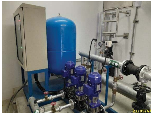
Booster Pump อาคาร X
